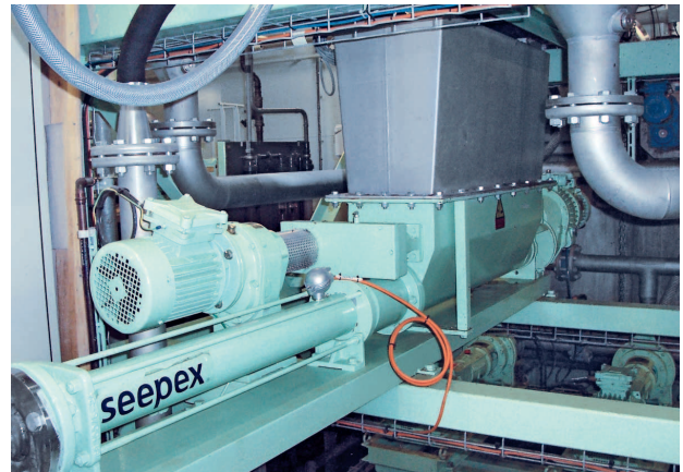
Pumpe der Baureihe BTI zum Fördern des entwässerten Schlammes in den Trockner.
