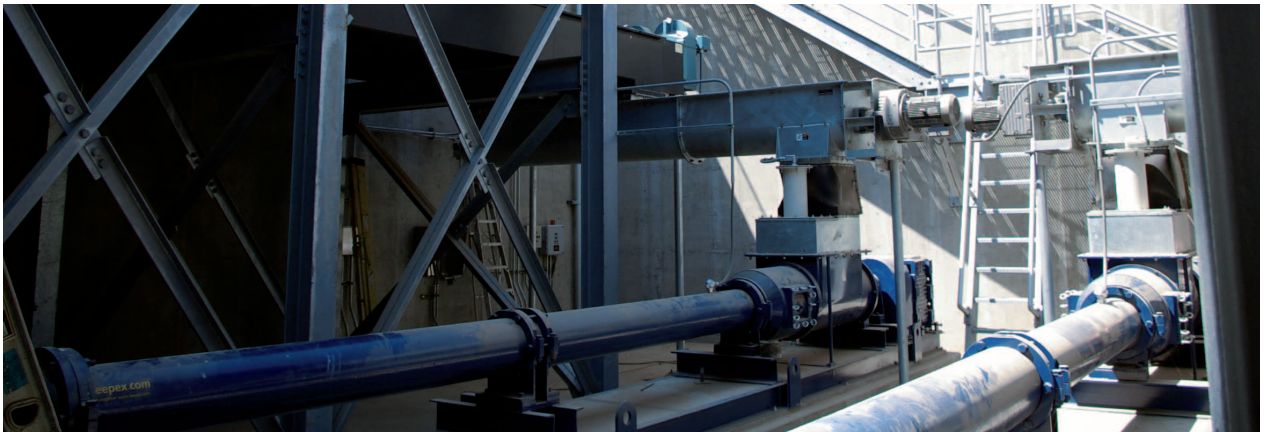
Zwei Hochdruckpumpen der Baureihe THE unterstützen ein nachhaltiges Konzept.
